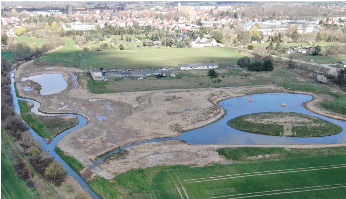
Kurz nach der Fertigstellung
