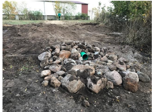
Zusätzliche Wassereinspeisung durch Regenwasserzufuhr von Dachflächen
