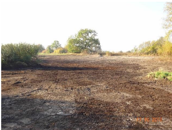
Nach Abschluss der Erdbauarbeiten
