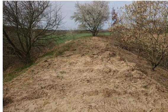
*Abb. 9: Oberer Wallbereich nach Entfernung der Folienabdichtung*
