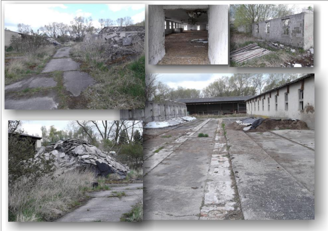
Abb. 1: Zustand vor der Entsiegelung
