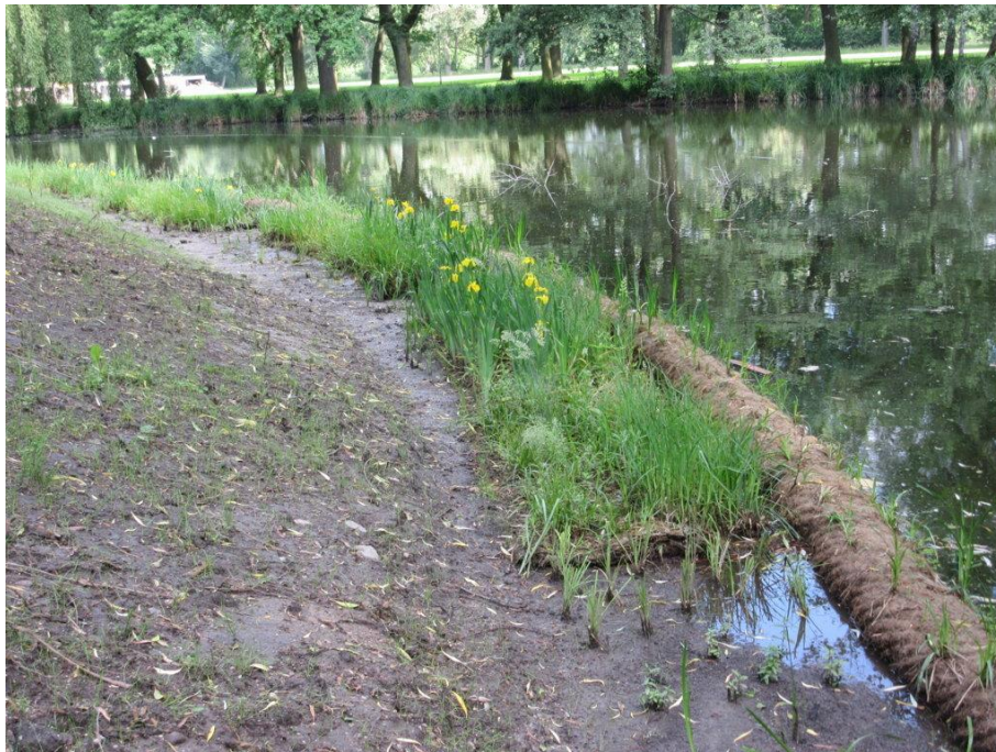
Abb. 4: Uferabflachung und neue Vegetation (Matten und Kokoswalze) während der Bauphase
