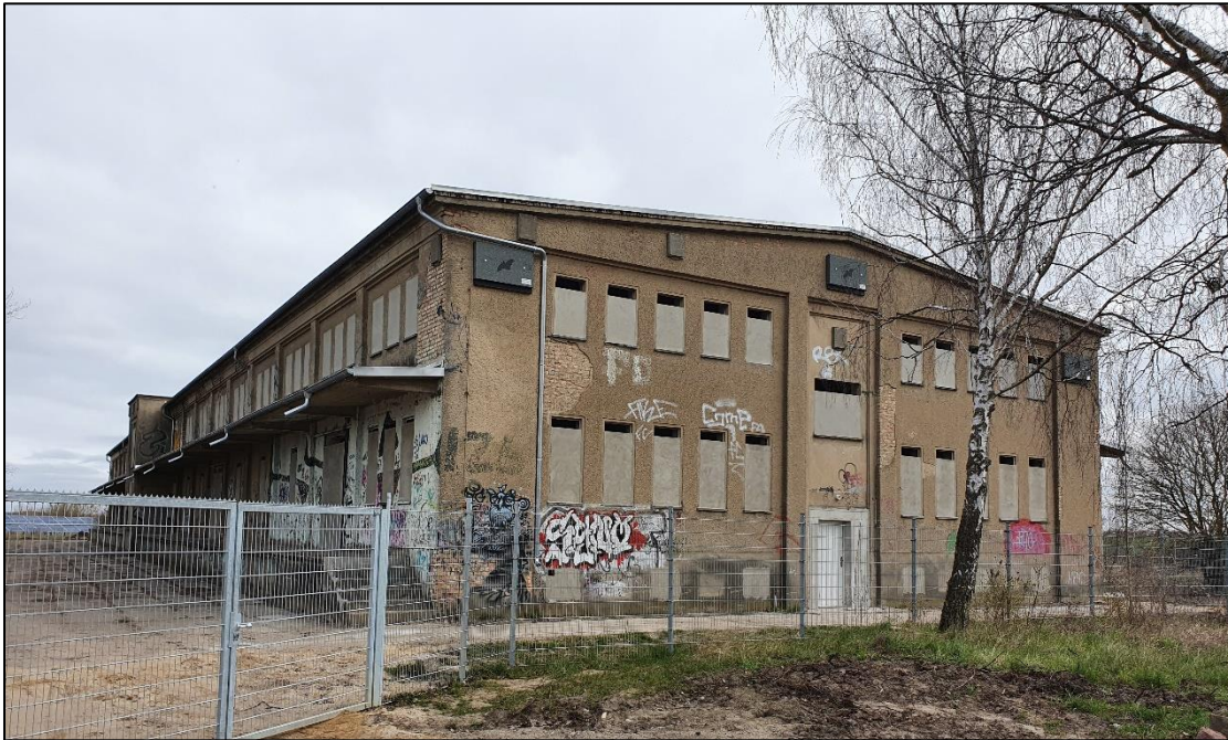
Außenansicht 01.04.2020 nach Abschluss der Bauarbeiten
